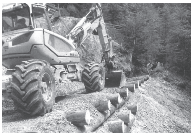
Exemple de mise en place d'un caisson en rondins de bois.
