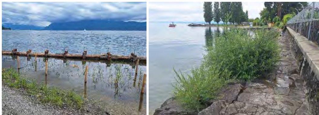
Figure 12. Plantation de roseaux protégée par une palissade en bois et buissons de saule se développant dans un enrochement riverain
