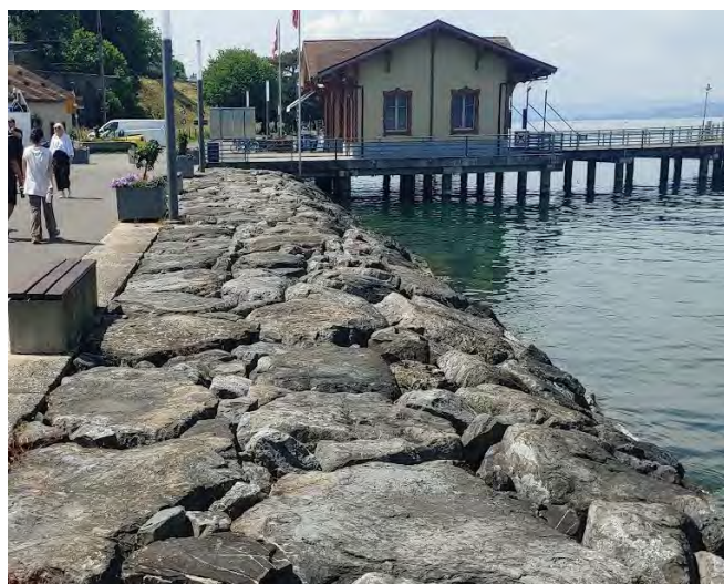
Principe de pose des enrochements
