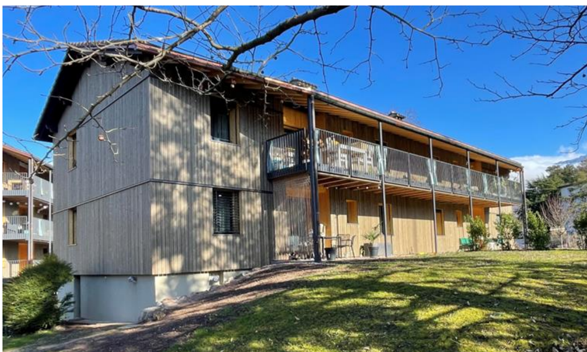
Bâtiment locatif rénové Ch. de Béranges 53
