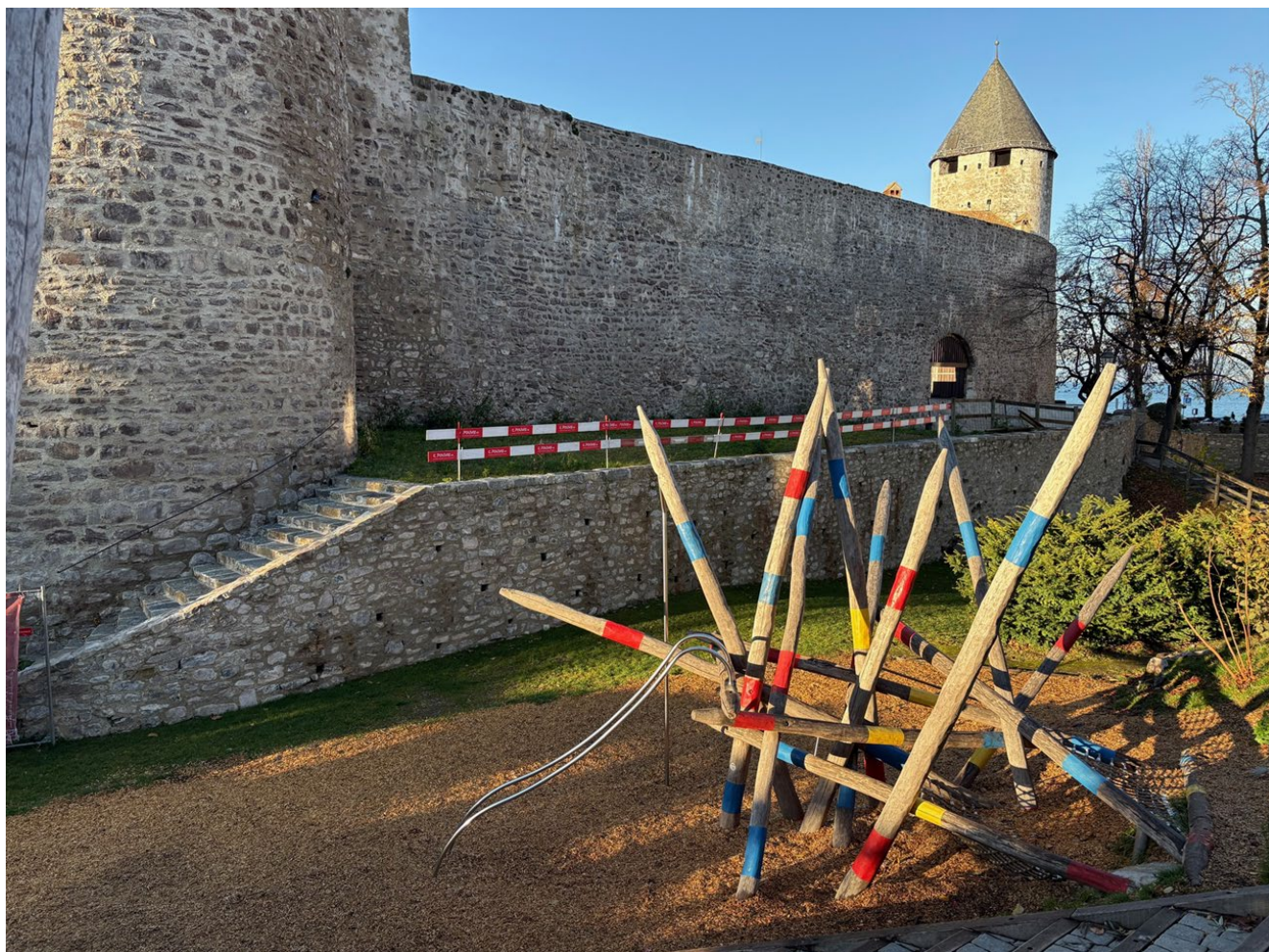
Photo de la situation avec place de jeux et murs rénovés
