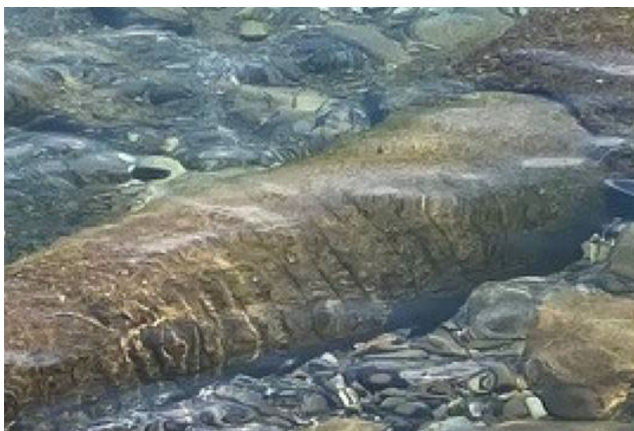
Etat du collecteur ciment – armatures apparentes
