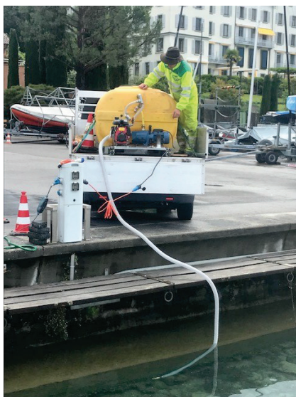
Dispositif mobile de pompage d'eau non-potable du lac afin d'arroser les espaces verts et massifs
