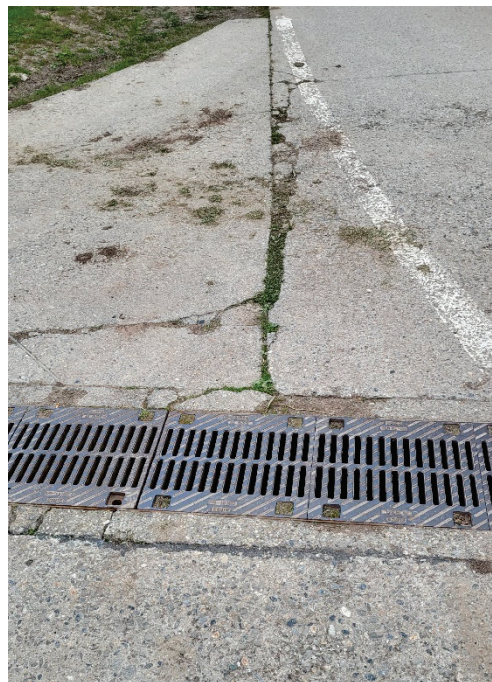
Revêtement actuel – Exemple de dégradations ponctuelles
