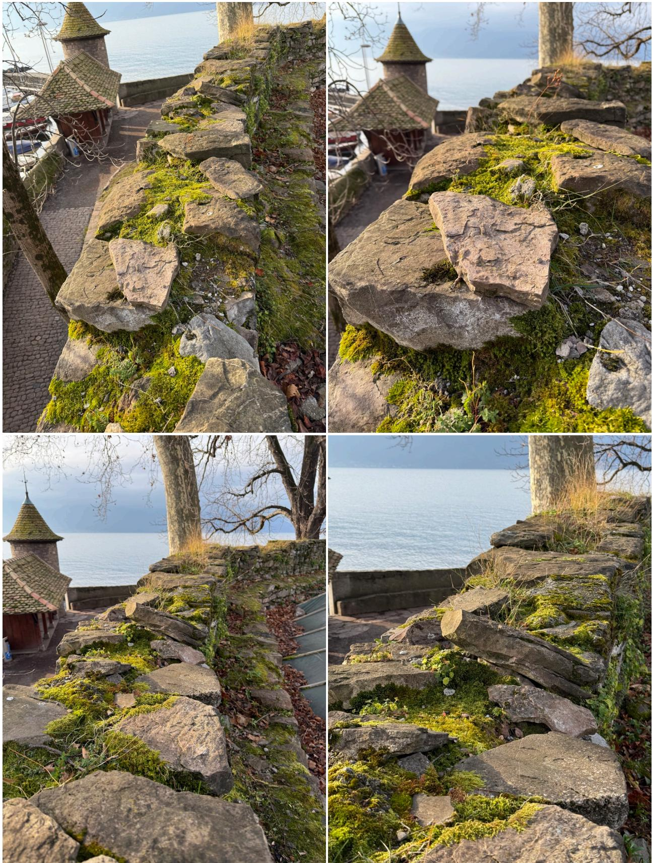
On constate une érosion du crépi laissant apparaître de plus en plus de moellons.
