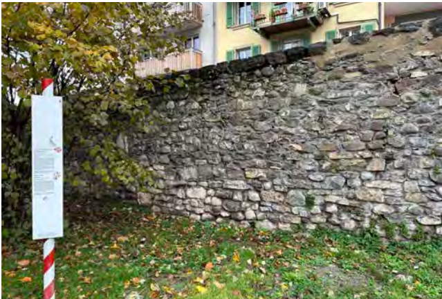
Moellons de réemploi.
