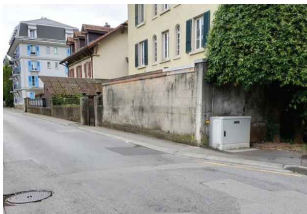
Clos d'Aubonne – accès latéraux des secteurs I et II (photos du 24 mai 2022)
