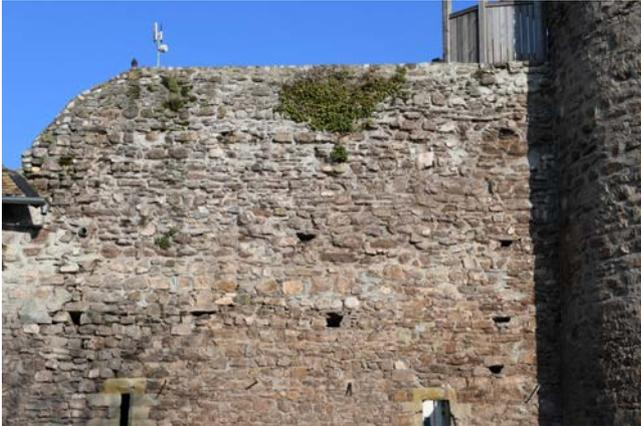
Le parement est ponctuellement jointoyé avec des crépis riches en ciment portland de facture moderne.
