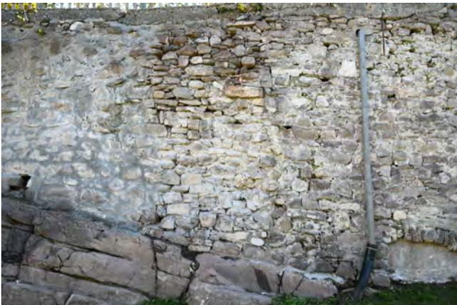
Déformation du parement en moellons et déchaussement des pierres
