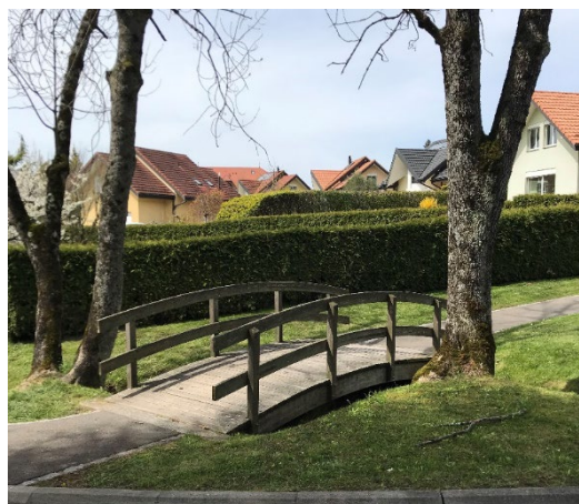
Figure 4 : Pont piétons actuel sur le Gregnolet
