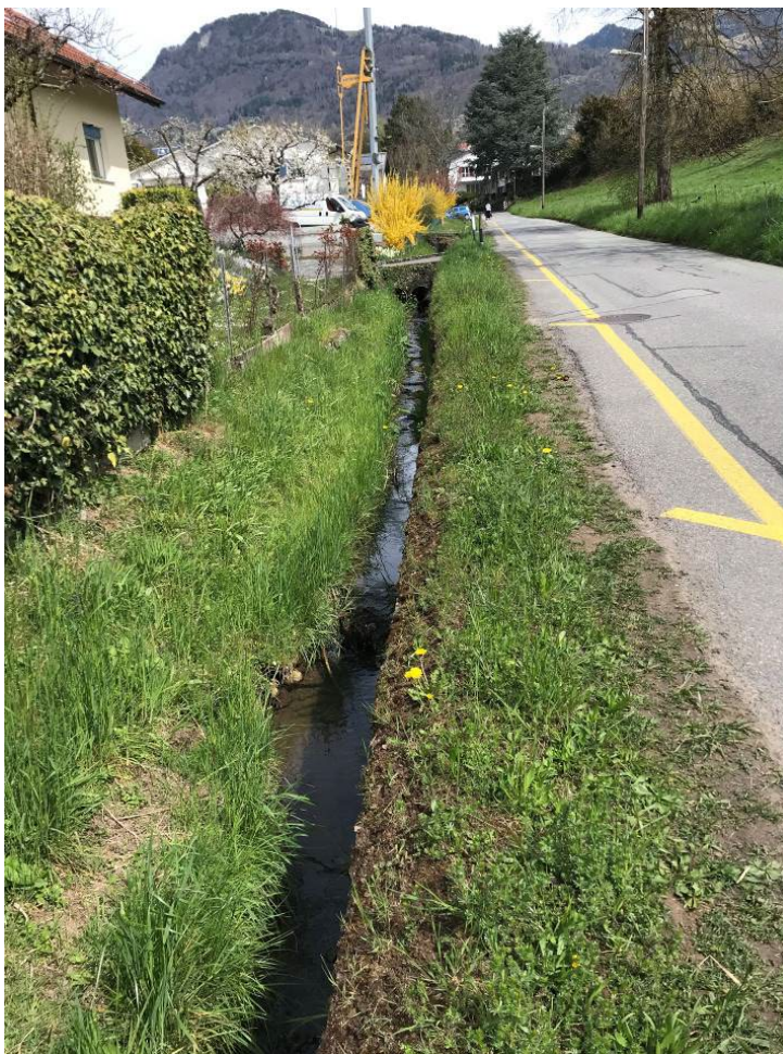
Figure 2: Etat actuel du ruisseau du Gregnolet
