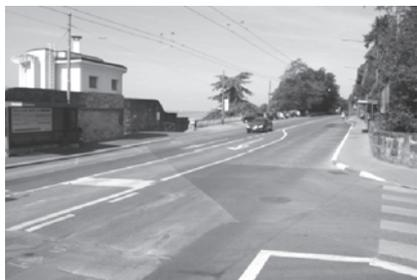
Sur base de la modification temporaire faite pour les travaux au chemin du Vallon, il a été décidé de modifier ce carrefour définitivement. Une présélection « tourner à gauche » sur la route de St-Maurice en venant de La Tour-de-Peilz et une adaptation du système de signalisation lumineuse ont été aménagées. Un accès direct au parking de la piscine pour les véhicules venant de La Tour-de-Peilz est désormais possible.
