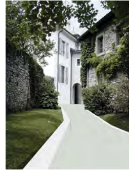
VUE DE L'APPROCHE DEPUIS LA CAVE VOÛTÉE
