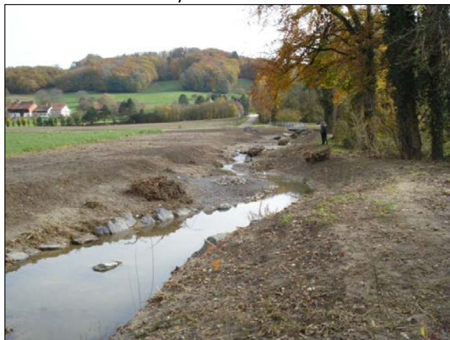
Exemple avant travaux
