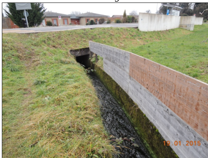
Caniveau et voûtage sous la RC
