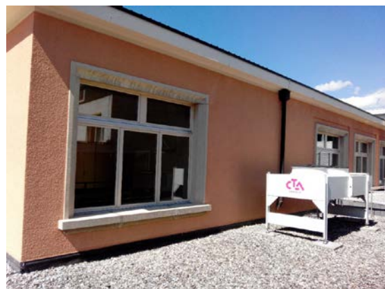
Emplacement adéquat pour les onduleurs : terrasse au Sud-Est
