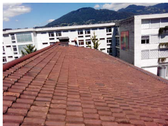
Pan Sud-Est. En contrebas, on voit la barre à neige, en retrait de laquelle s'arrête le champ de panneaux.
