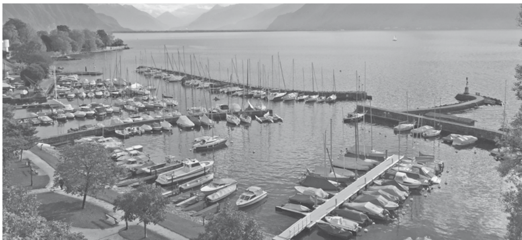
Renforcement par injection de béton de la digue de Vaudaire.
