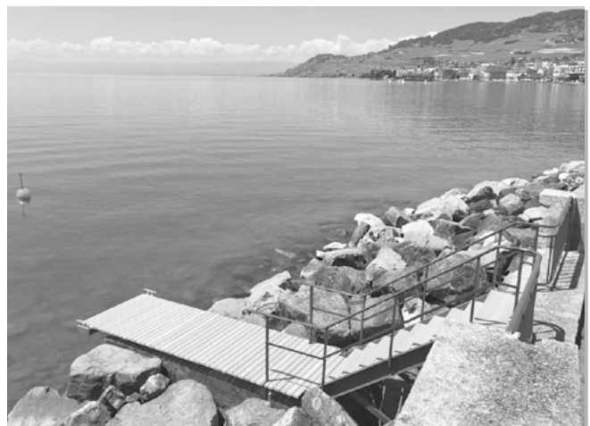
Réfection d'un ponton au quai Roussy avec deux bouées d'amarrages visiteurs.
