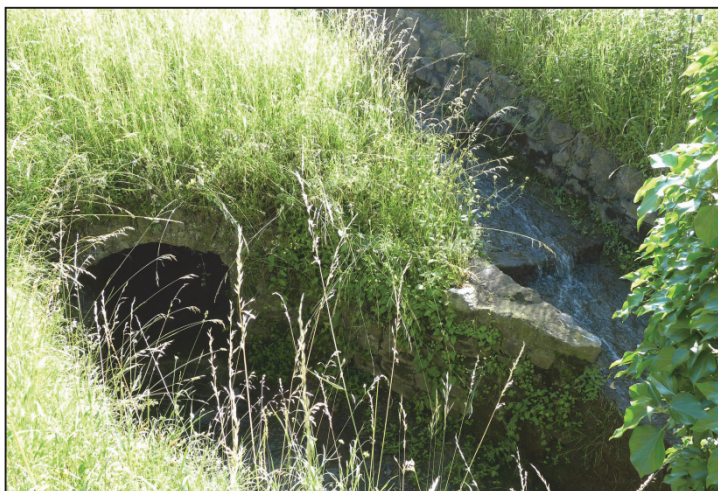
Figure 4 – Sortie du passage souterrain au dessous de la route de Chailly
