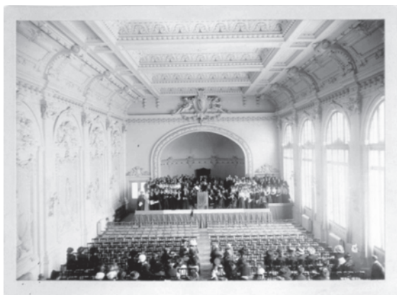
Vue de la salle avec la scène d'origine, qui sera ensuite entièrement transformée en 1955-1956
