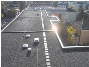
Toiture principale avant travaux
