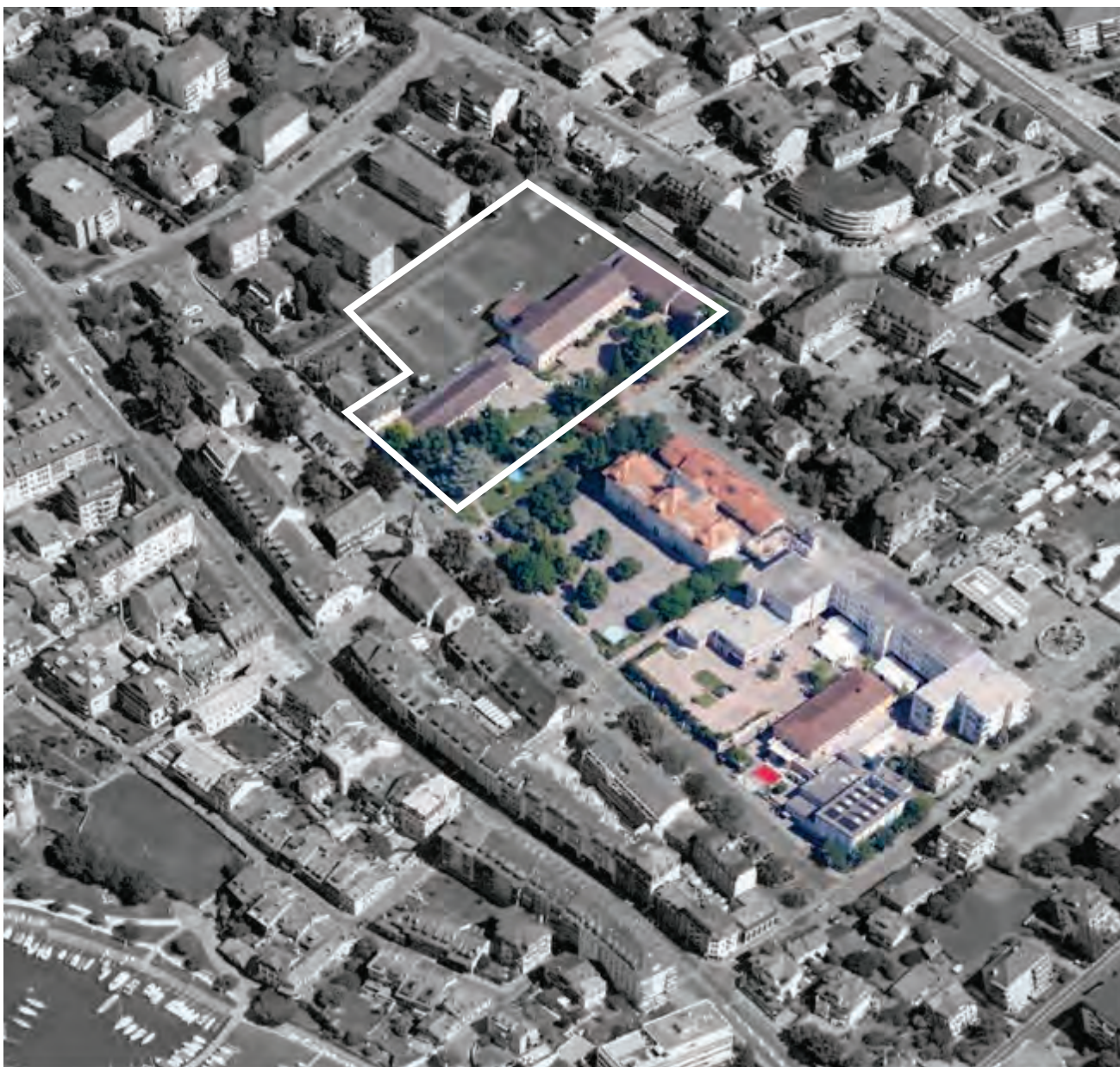
Vue aérienne du quartier des écoles et emplacement du projet
