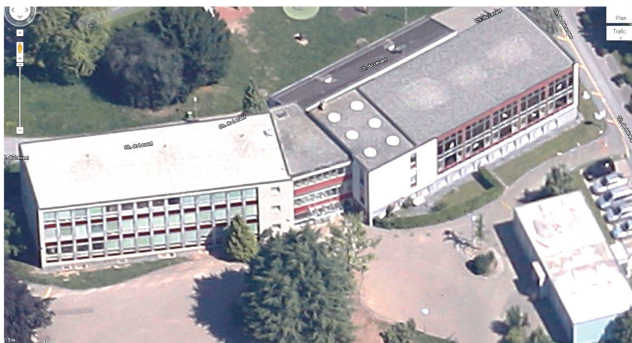
Vue aérienne des toitures du collège de Bel-Air et de sa salle de gym
