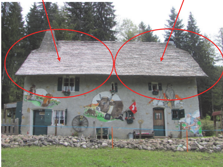
Pan nord de la toiture qui montre la moitié restaurée et l'autre dégradée
