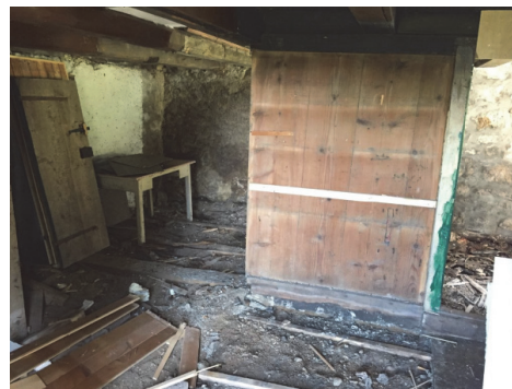
Démontage des revêtements des murs et sols (photos mai 2016)
